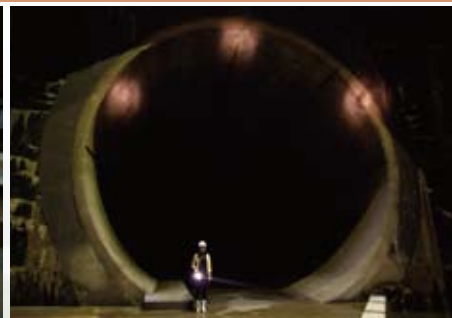
第3立坑のトンネル開口部
