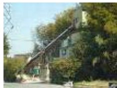
生コンプラント
