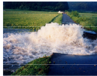
管からの漏水に伴う農地への湛水及び農作物被害状況（坂祝支線PC管）
