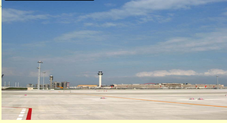
工事状況(全体図)
