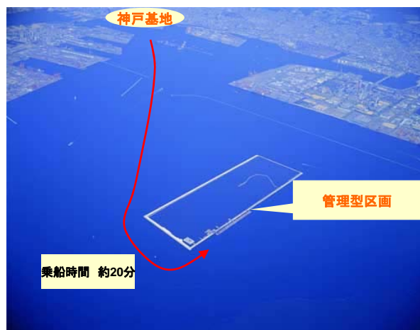
写真2 神戸沖埋立処分場
