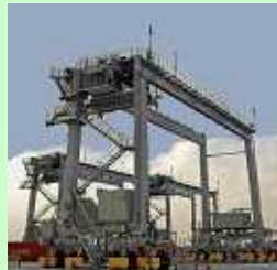
遠隔自動RTG (ラバータイヤ式ガントリークレーン)
