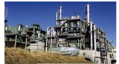
下水汚泥焼却炉
