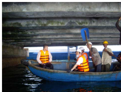
港湾構造物の点検・診断 に関する現地実習状況
