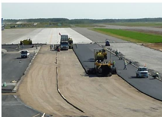
【誘導路舗装の改良】
