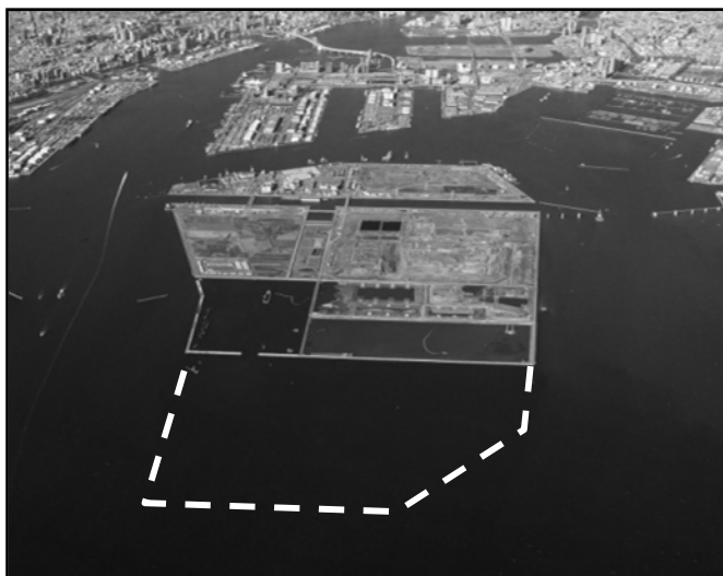
【東京港 海面処分場】
