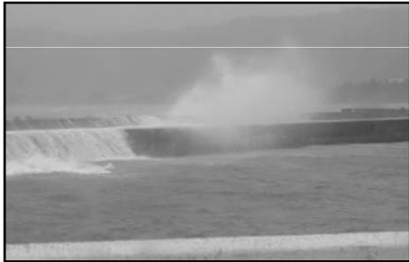
【港内静穏度確保のための防波堤】
