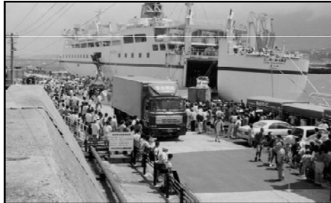
【船舶の大型化に対応した岸壁】
