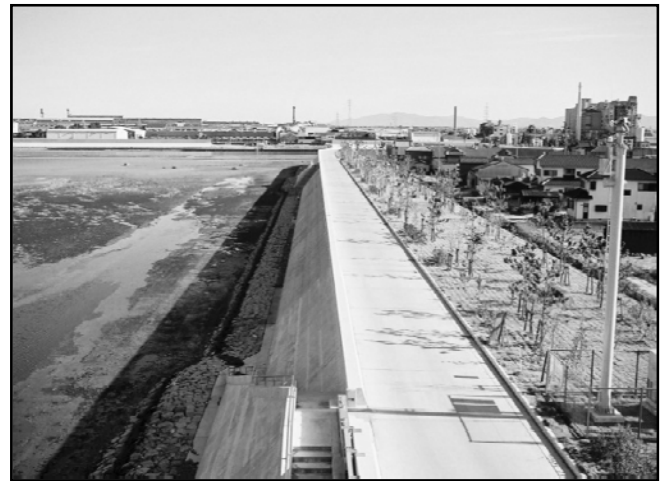
整備後（平成16年）
