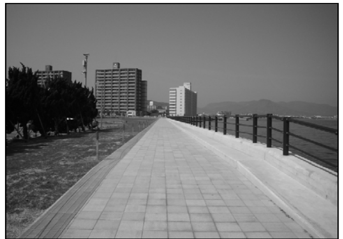
整備後（平成20年）
