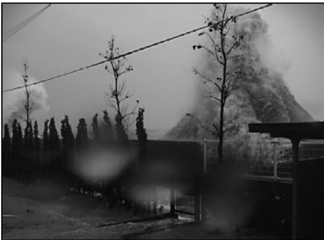
平成16年 台風23号による越波状況
