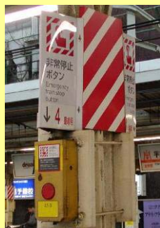
非常停止押しボタン
