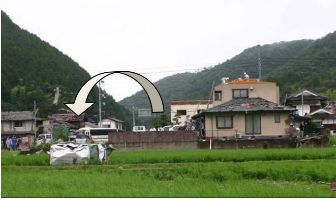
写真3 屋根が飛散した住家と水田に飛散した軽自動車 (美作市撮影)
