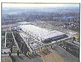
Eur 03 エレクトロラックスポーランド洗濯機工場
