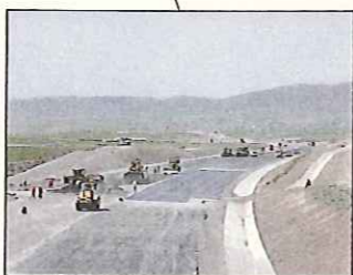
K 01 アルジェリア東西高速道路建設工事
