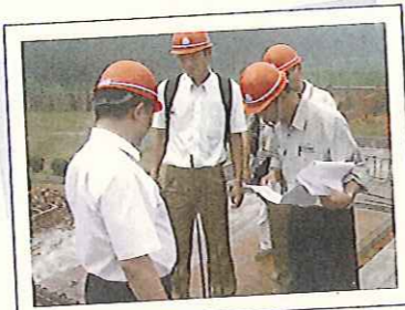
施工中の現場を確認する鹿島社員(右)
