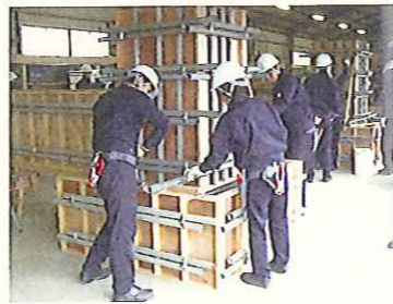
型枠組立の実践研修 (建築部門)
