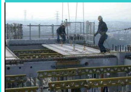
④KH床版スラブ筋
