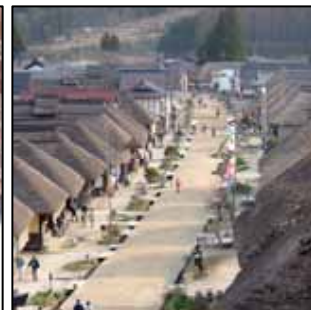
〔裏配線の整備事例〕
