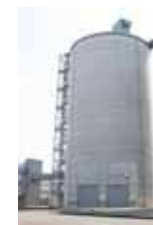
石炭灰保管施設 (姫川港)
