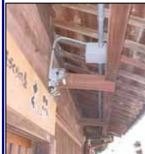
〔軒下配線の整備事例〕
