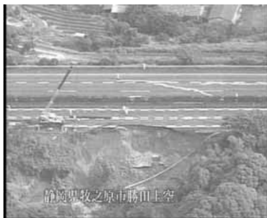
地震で法面路肩部が崩壊した東名高速道路上り線（静岡県牧ノ原市）
