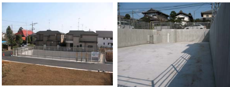
〈雨水貯留浸透施設の例〉
