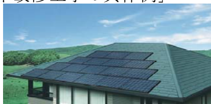
窓の断熱性の向上や 太陽光発電の導入
