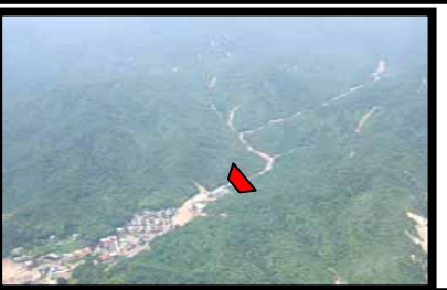
奈美川(なみがわ) 8/7 ~ 砂防えん堤工 1基(高さ約9m)
