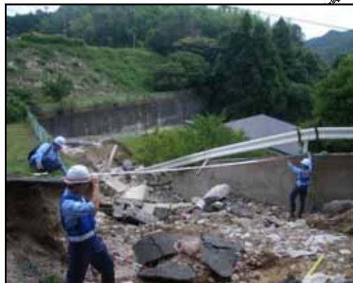
被災状況調査
