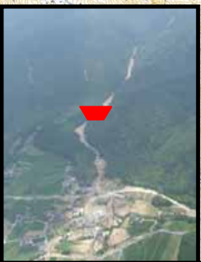
上田南川(うえだみなみかわ) 砂防えん堤工1基(高さ約11m) 7/31 ~
