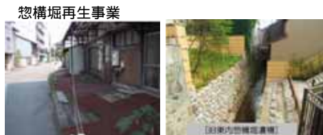
【暗渠区間の開渠化】 【整備済箇所】
