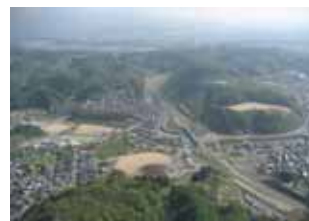
図 6 金沢外環状道路東長江町付近(石川県)
