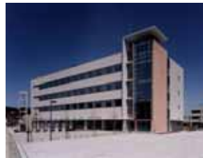
図 12 グリーン庁舎「七尾西湊合同庁舎 1 号館」(石川県)
