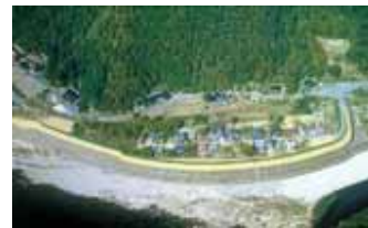
河川堤防の整備
