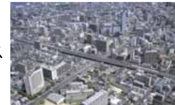
大分駅付近連続立体交差事業
