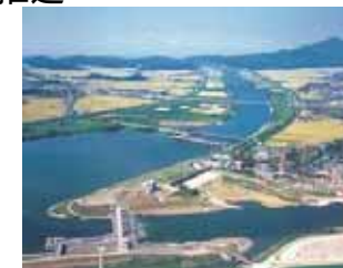
大河津可動堰改築
