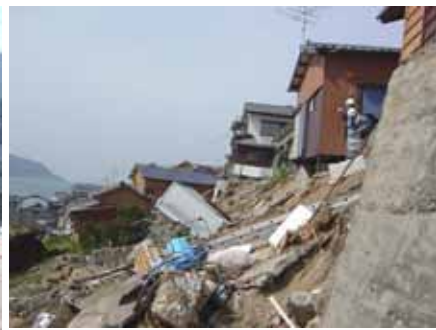
写真: 福岡県西方沖地震
