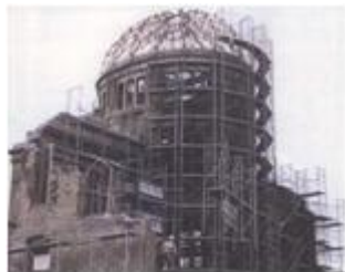
原爆ドーム改修工事
