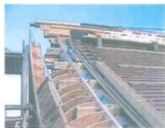
成田山川越別院改修工事(屋根部分)
