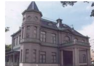
旧福岡県公会堂貴賓館(重要文化財)震災復旧
