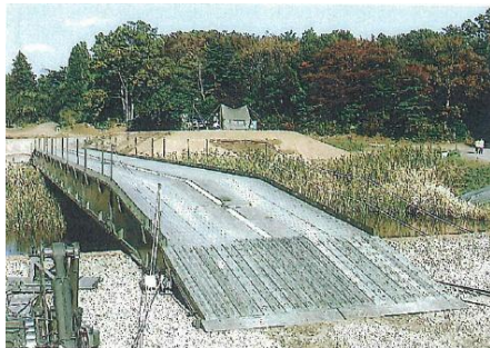
架橋システムの外観
