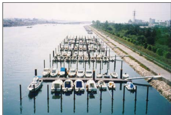
静穏水域を活用した整備事例（東播磨港）
