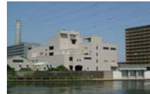
ポンプ場の整備 (東京都 神谷ポンプ場)
