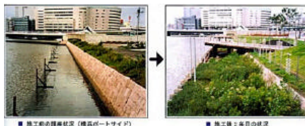
■ 施工前の護岸状況 (横浜ポートサイド)
