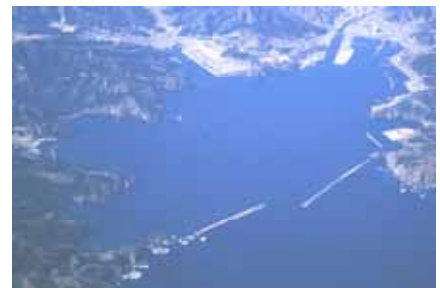
図11 釜石港湾口の津波防波堤 (H20年度完成)
