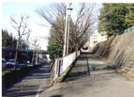
・バス停と住宅地を繋ぐスロープ
