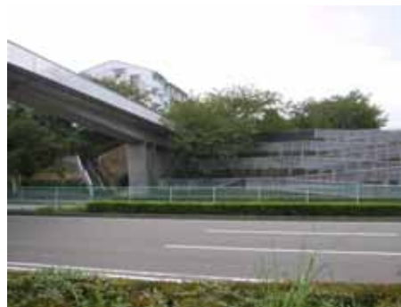
・長い急勾配スロープ(勾配1/10)
