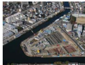
高度処理施設の建設
