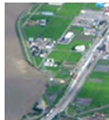
天竜川上流堤防決壊 (H18.7) 出典: 中部地方整備局資料
