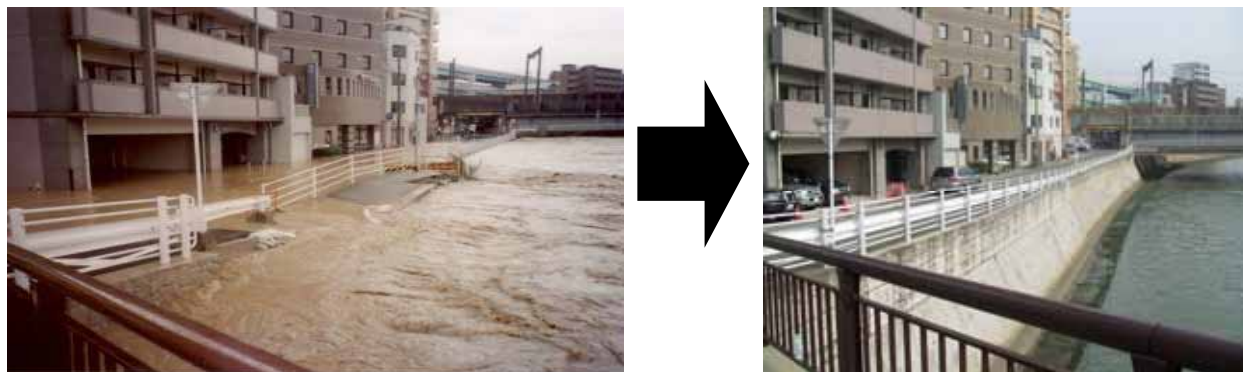
図4 平成15年福岡豪雨災害 河川激甚災害対策特別緊急事業(御笠川 H19年)
