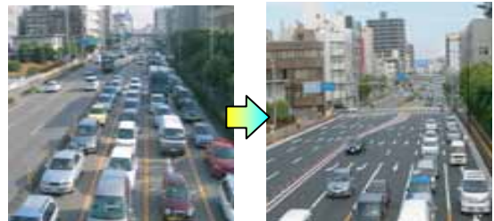
図 7 国道 11 号徳島本町交差点改良 (徳島県徳島市)
