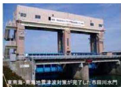
図5 市田川水門緊急自動急閉システムの完成
