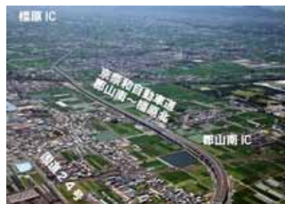
図4 京奈和自動車道(郡山南～橿原北)の整備
