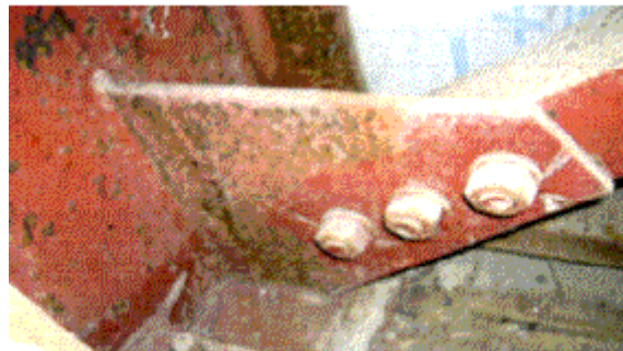
保有耐力接合となっていないブレース接合部
