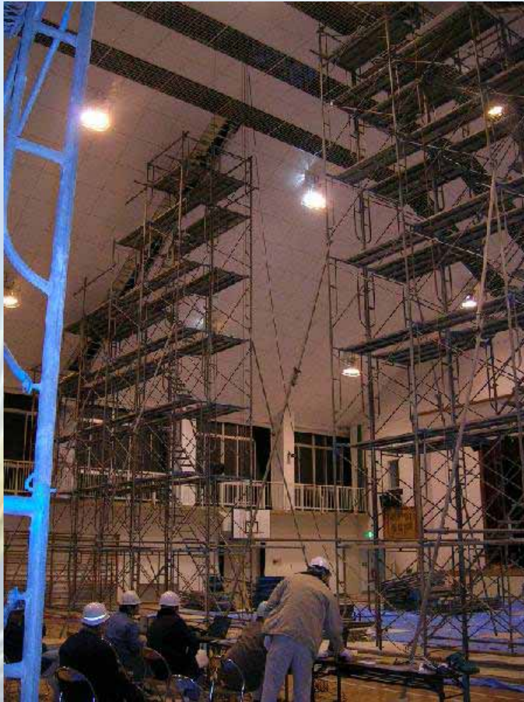
体育館Aの測定状況 (仮設足場を設置)
