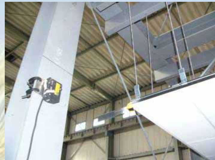
天井に取り付けた変位計
