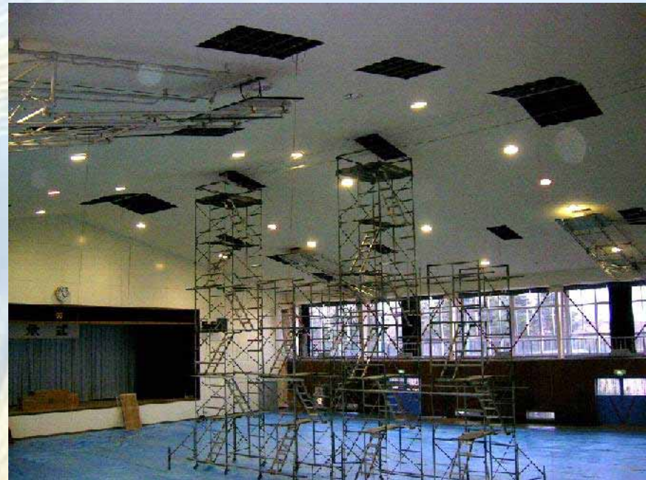
体育館Bの測定状況 (ローリング足場を設置)
