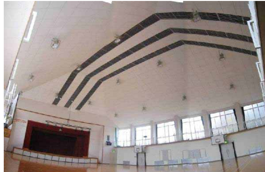
修復後の現在の状況
