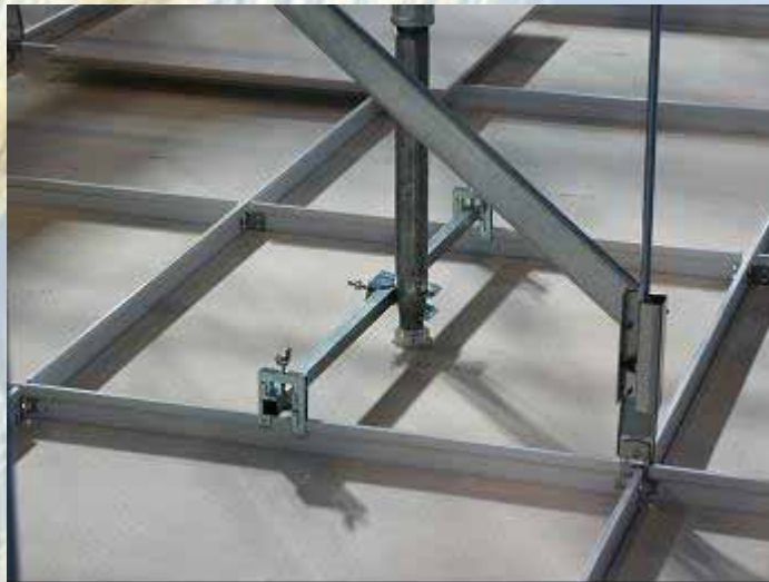
在来実管方式の配管固定方法
