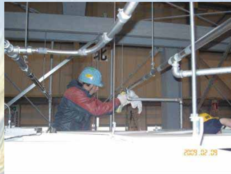
SP配管空気漏れチェック
