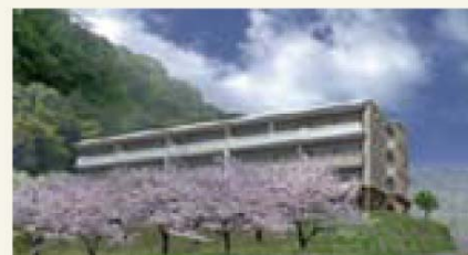
(仮称)グランリビオ高見式番館(北九州市八幡東区)
