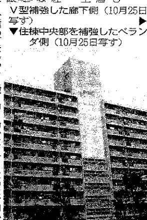
26-4号棟の耐震改修工事。左側は廊下側(10月25日写す)、右側はベランダ側(10月25日写す)の補強の様子。
