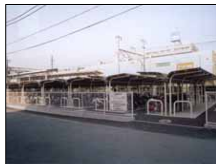
駐輪場の整備
