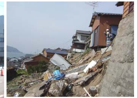
写真: 福岡県西方沖地震
