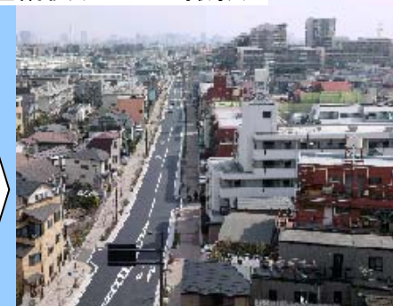
整備後(H19. 3撮影)
