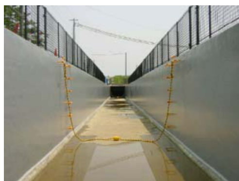
補強工事完了
