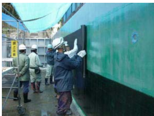
炭素繊維シートの貼付け
