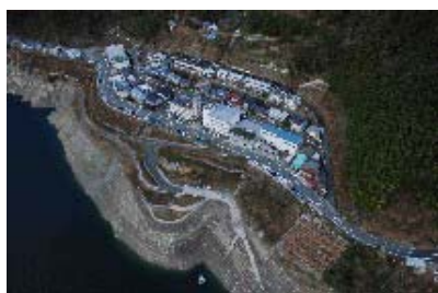
(小松地区) 管理用道路、環境保全施設、防護策、広場整備水路工、親水護岸、アンカー工等
