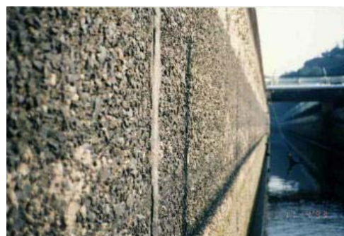
コンクリート面の状況
