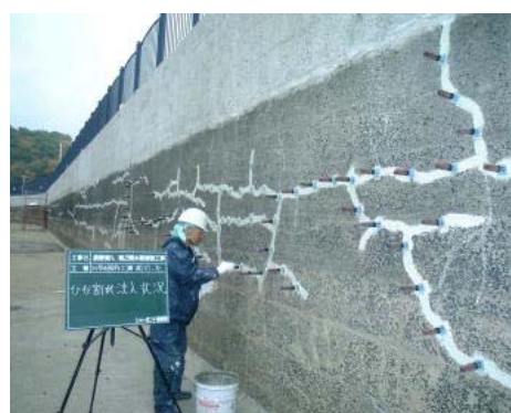
ひび割れ箇所の樹脂注入充填
