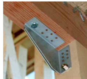
【仕口部の補強例】
