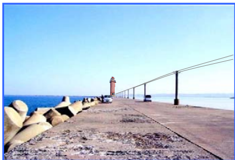
従来（配電線路）
