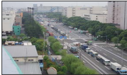
CTに接続する臨港道路
