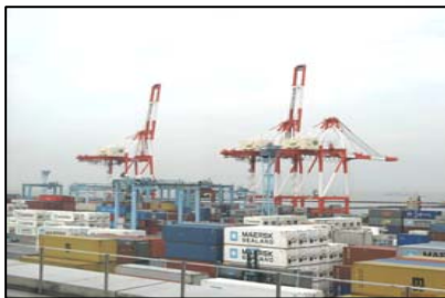
荷役機械の高度化による作業効率化
