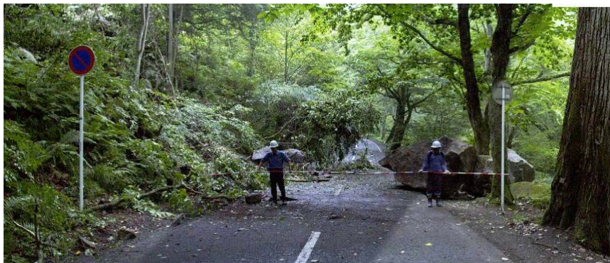
国道102号への落石状況
