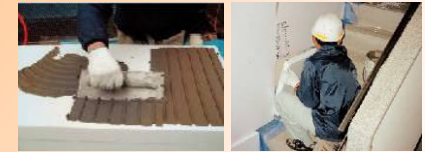
＜外断熱改修の施工風景＞
