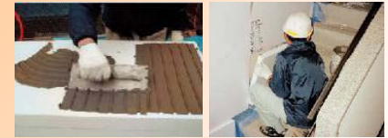
＜外断熱改修の施工風景＞
