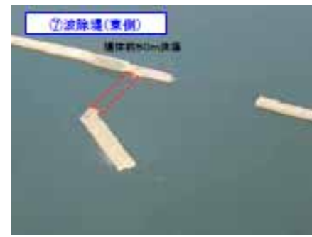
新湊地区波除堤の決壊
