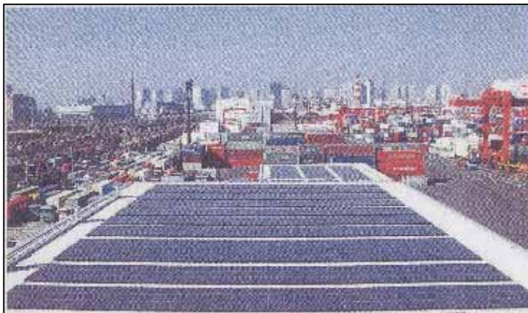
ゲート屋根へ太陽光パネルを設置
