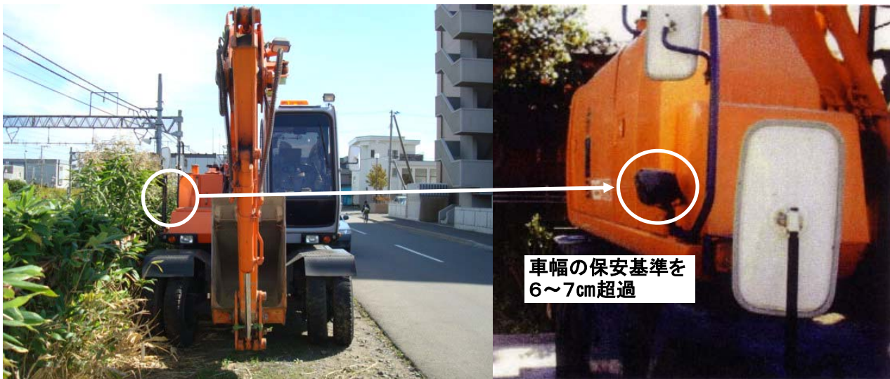
作業灯の取付
